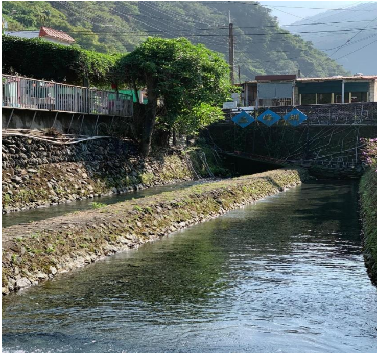
引水工程隧道出口
